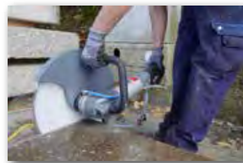
Système de séparation rapide pour remplacement des outils
