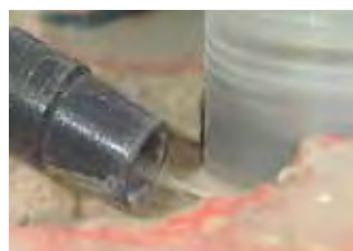
Aspiration des boues de chantier
