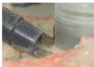
Aspiration des boues de chantier
