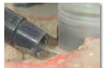
Aspiration des boues de chantier
